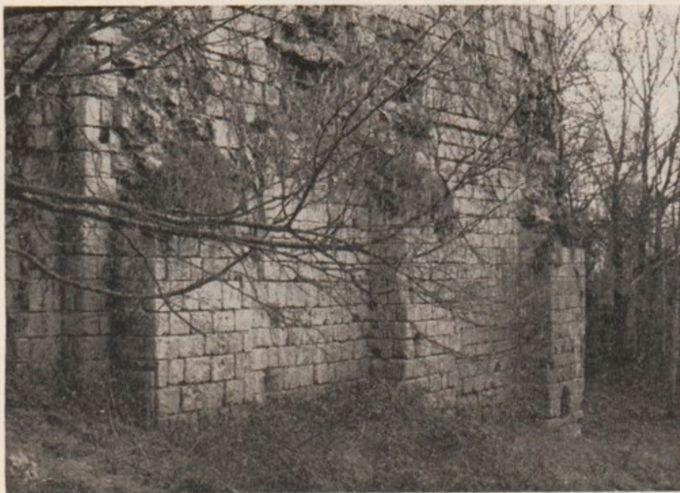
Extérieur : mur occidental. Notez la faible saillie des contreforts
