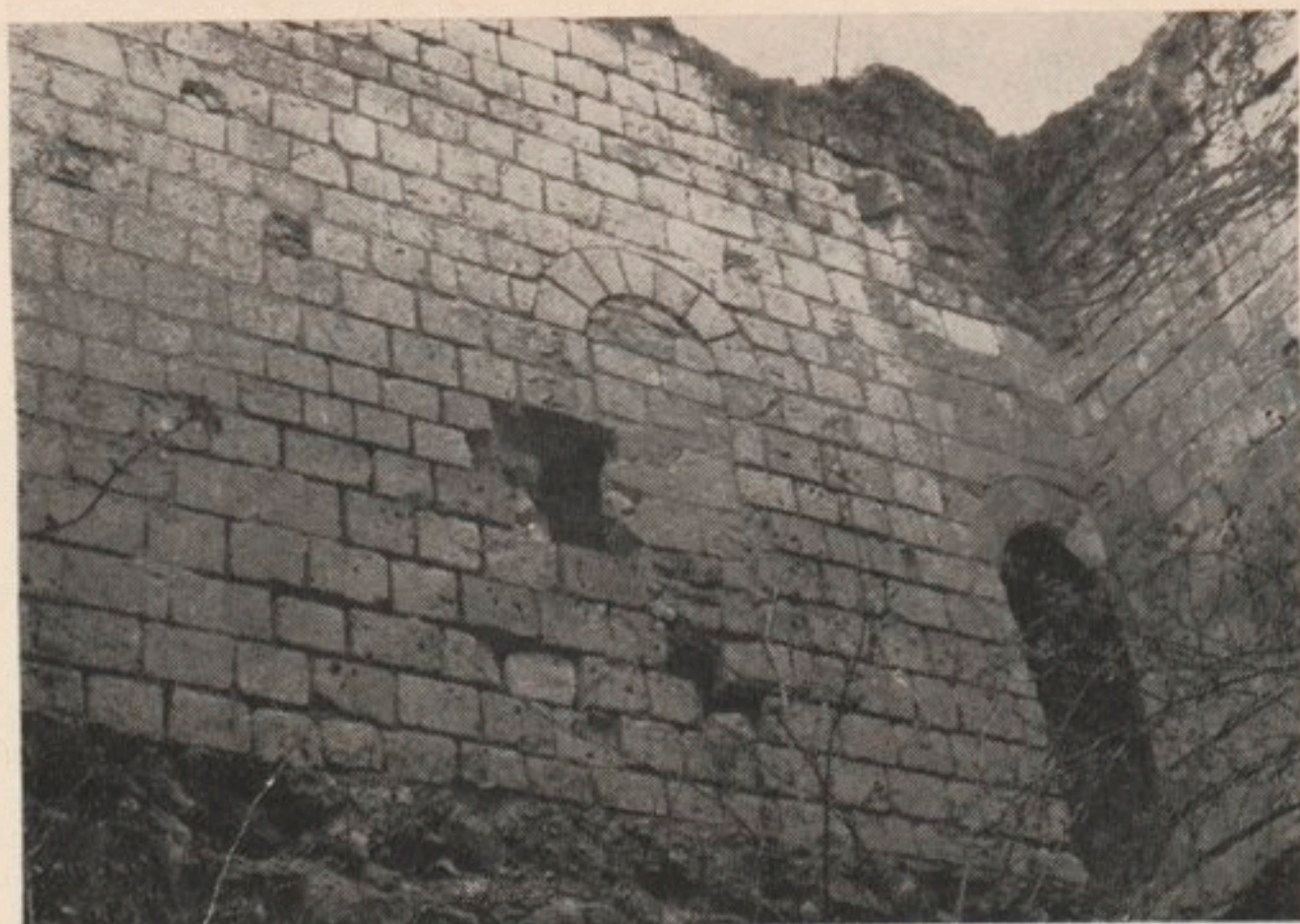
Mur oriental : contrefort médian et fenêtre au-dessus. Notez la puissance du contrefort médian
