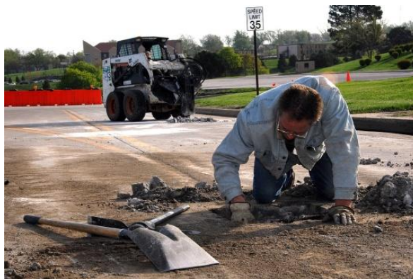
Cavilien redémarrant un trou endommagé
