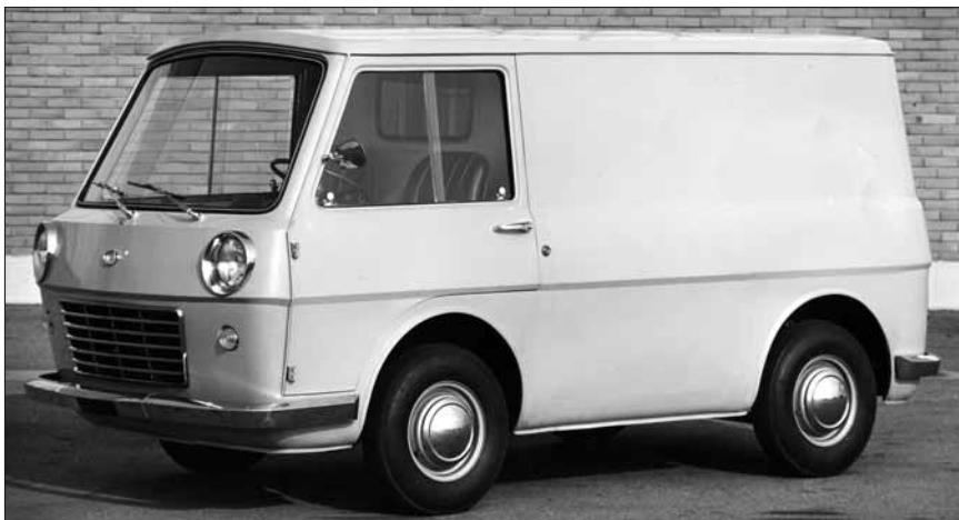
Le prototype d'une fourgonnette de 800 kg avec un moteur A40 construit en collaboration avec Carrozzeria Boneschi en 1965.
